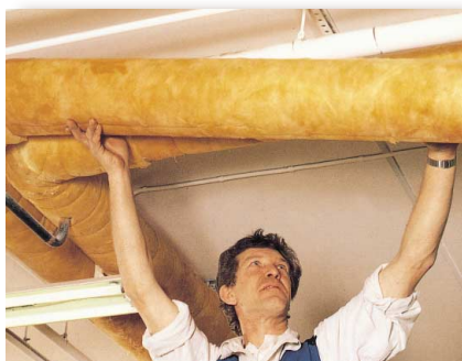
Aislamiento de tuberías
